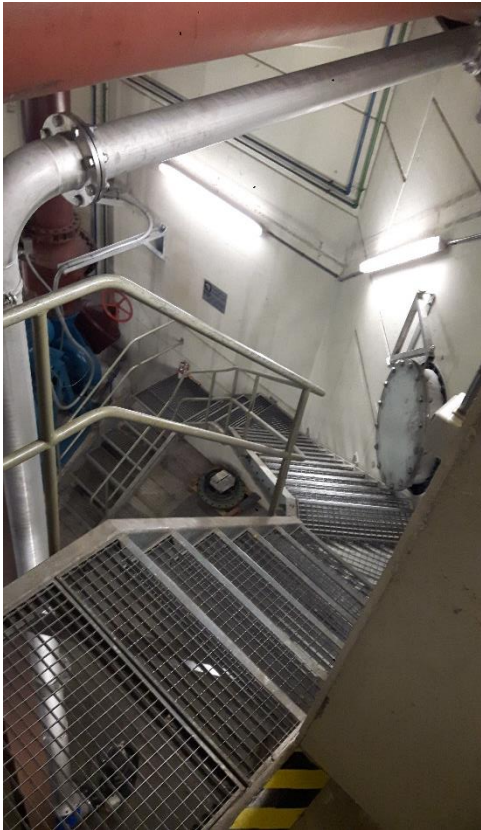
Notleitung Zulaufhebewerk
