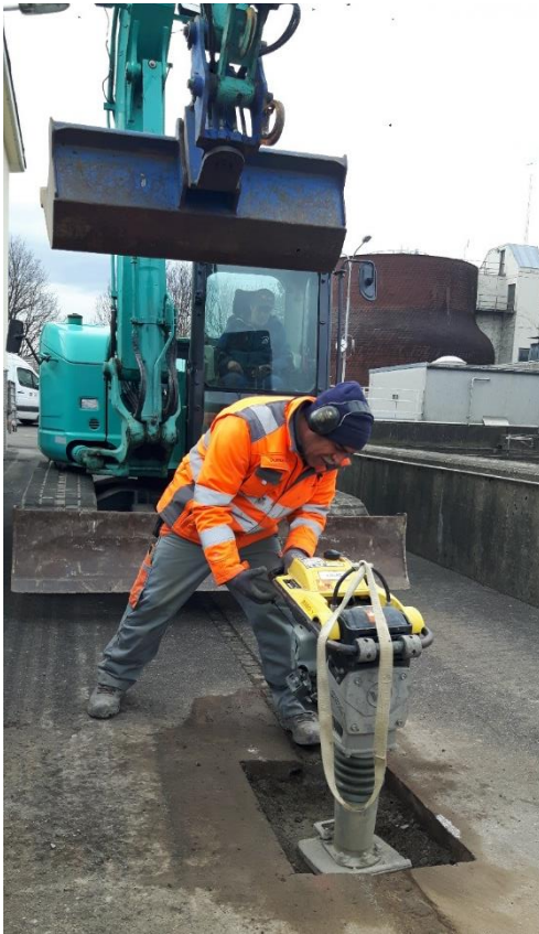
Sanierungen am ARA Gelände
