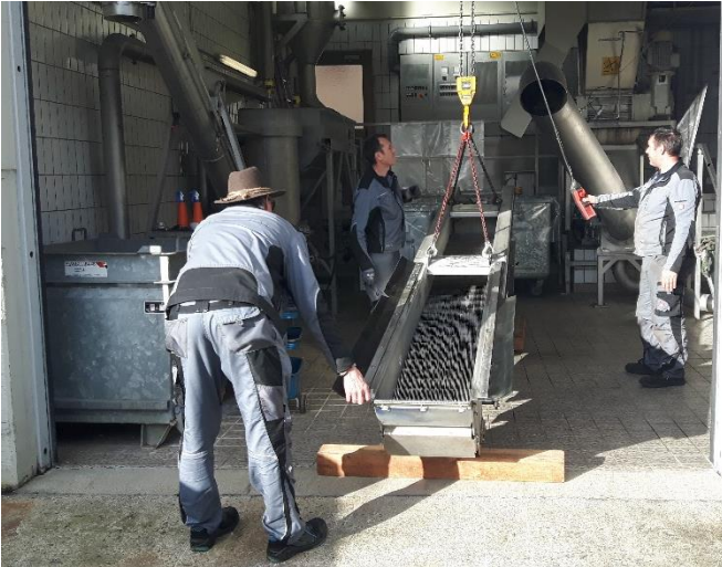
Austausch BHKW-Abgaswärmetauscher
