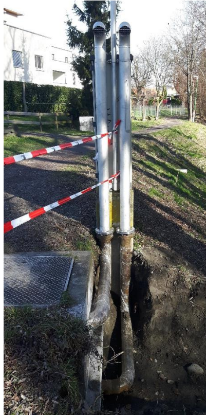
Optimierung Schachentlüftung Pumpwerk Neuburg
