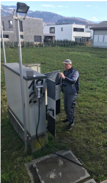
Notstrom-Maßnahmen bei den Pumpstationen (ARA ist schon mit 800kVA Notstrom-Aggregat versorgt)
