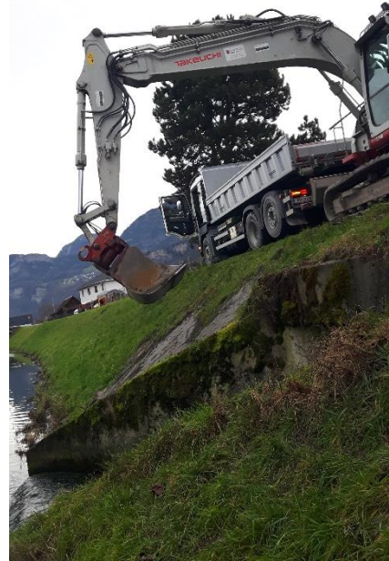
Behebung Hinterspülung ARA-Auslauf
