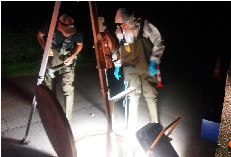
Austausch Gesamtzulaufmengenmessung
