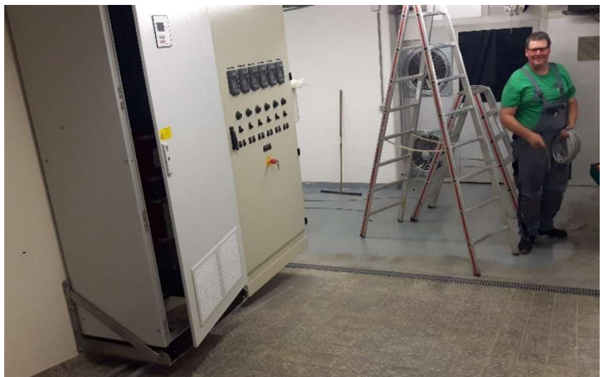
Schaltschrank f. Blindstromkompensation
