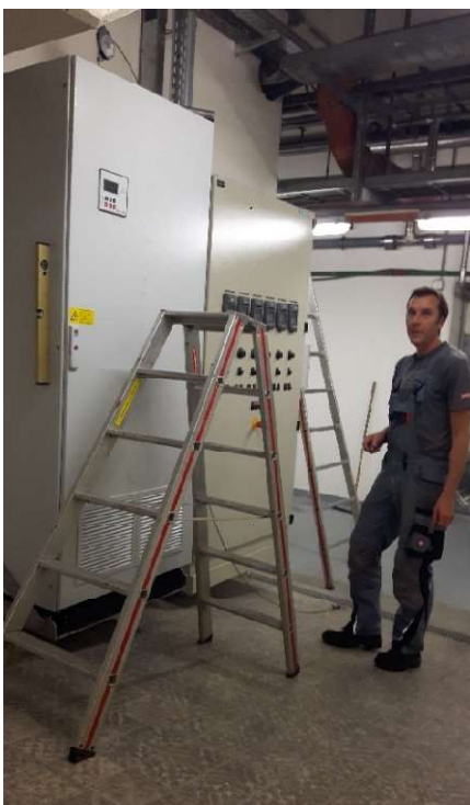
Schaltschrank f. Blindstromkompensation
