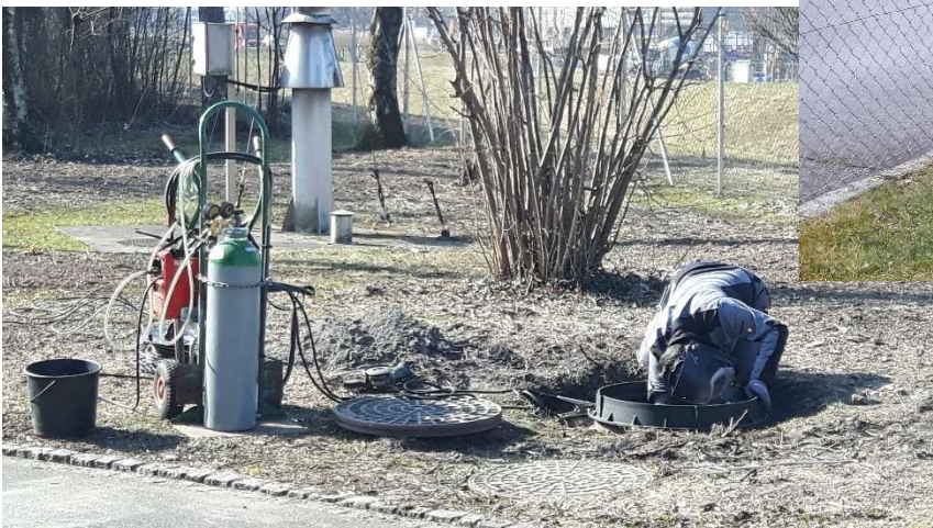
Fäkalien-Annahmetrichter + Unterflur-Schweißarbeiten
