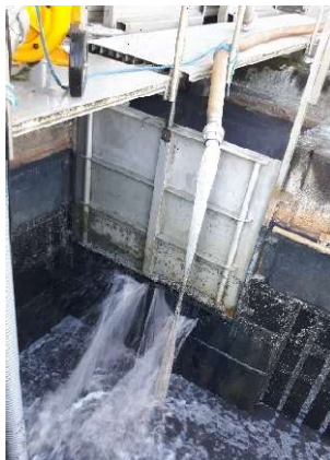
Schieber undicht...
