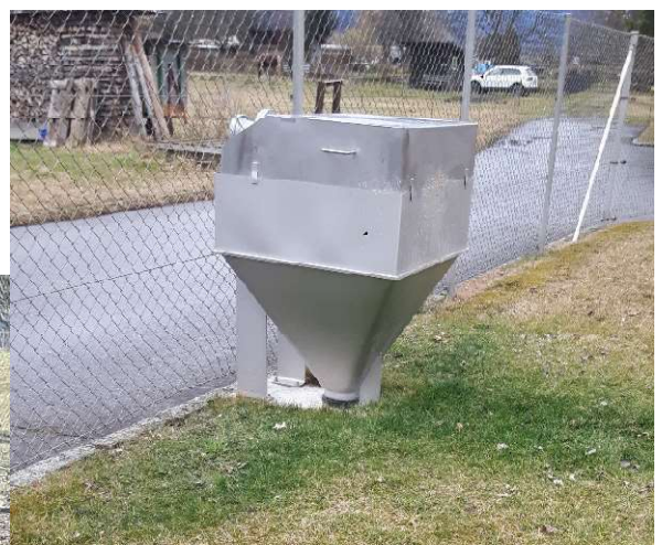
Fäkalien-Annahmetrichter + Unterflur-Schweißarbeiten
